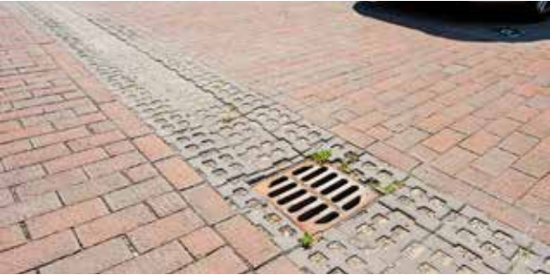
infiltratie in de molgoot
